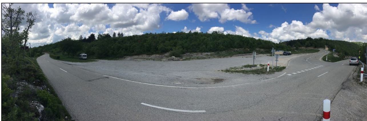
Intersection RD950 / RD5, avec dégagement routier – état initial
